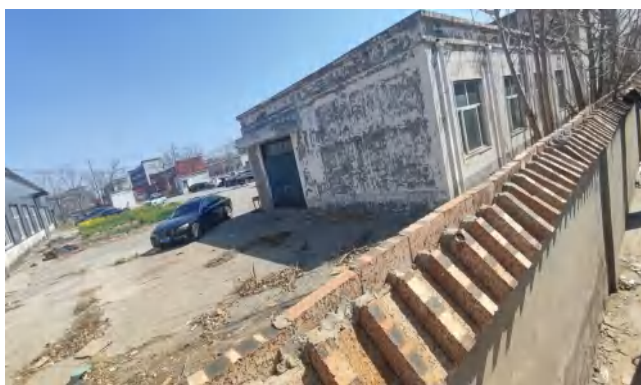
项目东侧闲置厂房
