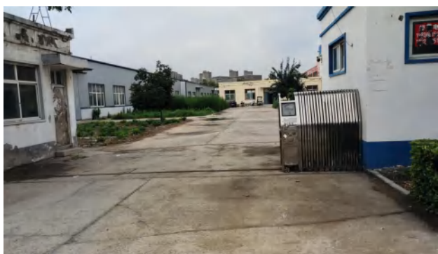
项目北侧闲置厂房
