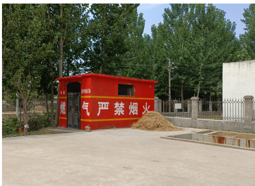
高平镇燃气东门站
