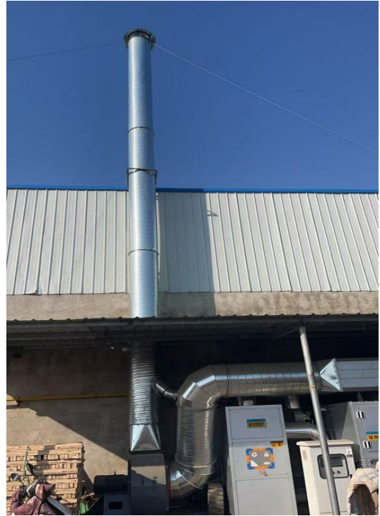
有机废气处理装置及排气筒
