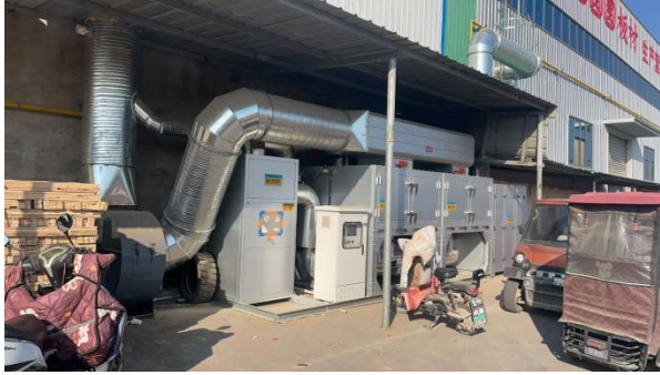
有机废气处理装置及排气筒
