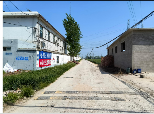
变电站南侧围墙外
