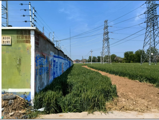
变电站东侧围墙外
