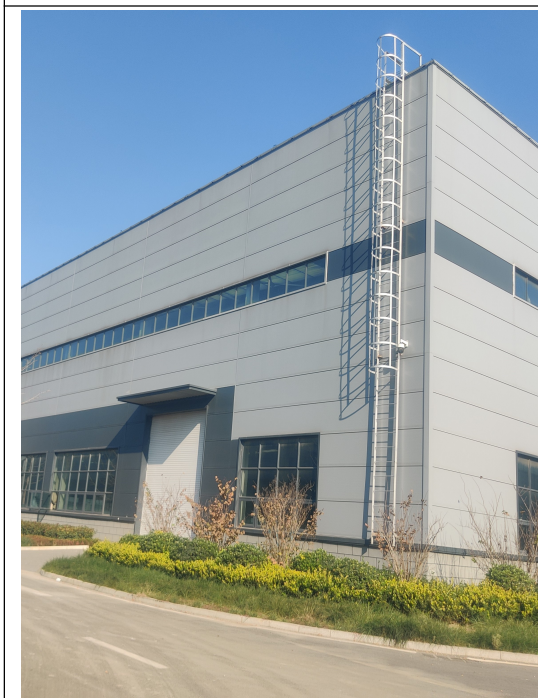
项目东侧-闲置厂房
