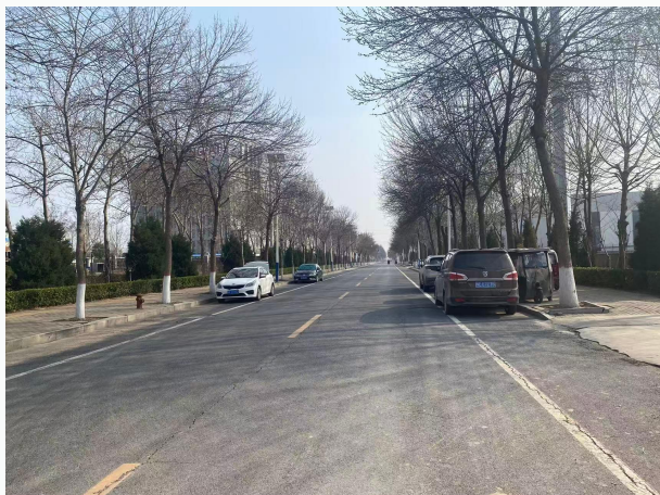
厂界东侧白马路
