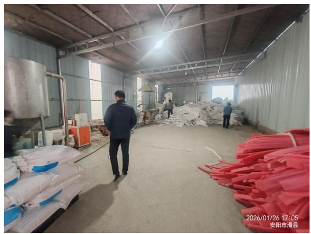
本次扩建工程车间现状
