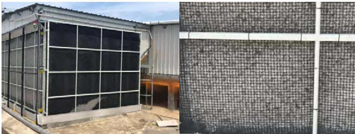
图 6.2-2 三防猪舍臭气处理装置示意图及实景图
